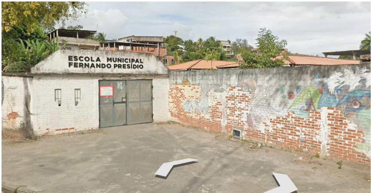
Figura 21 – Frente da Escola Municipal Fernando Presídio
