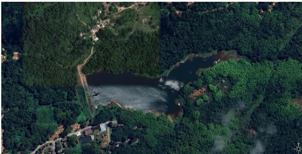
Figura 2 – Visão aérea da Barragem do Rio dos Macacos (ago/2025)
