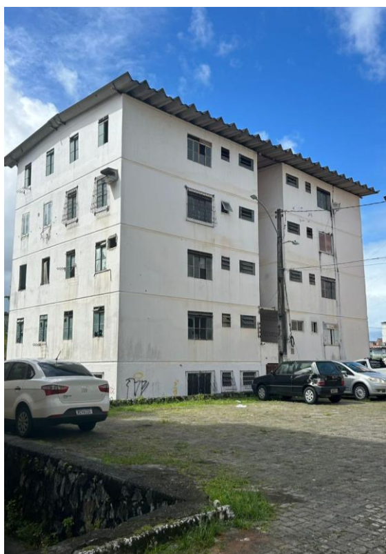
Figura 19- Imóvel abandonado na Sussuarana
