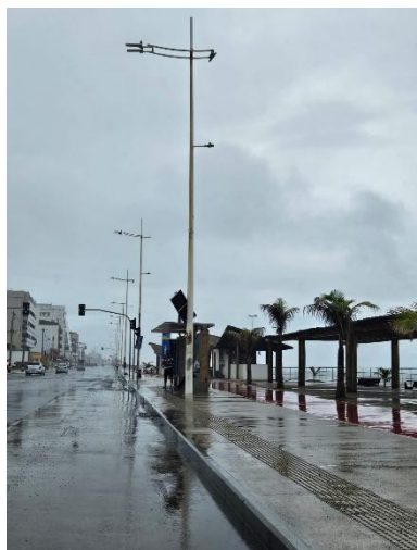
Figura 41 - Placa de sinalização do BRT instável
