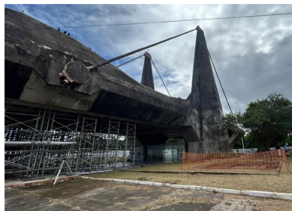
Figura 22 - Imóvel em desuso no CAB
