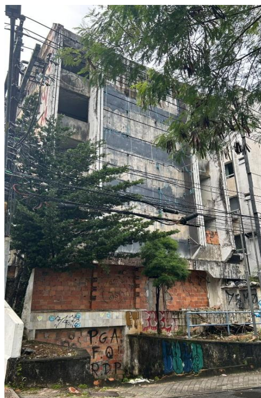
Figura 20- Imóvel abandonado na Federação
