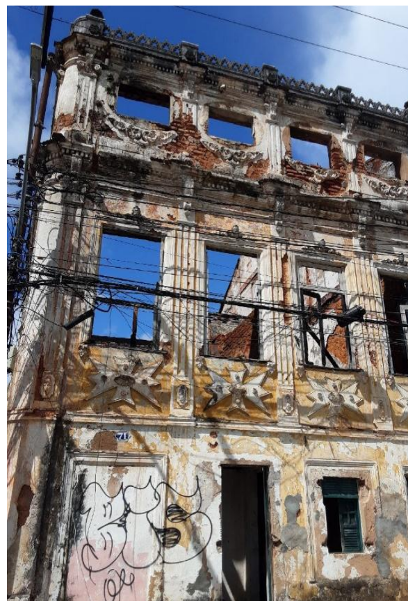
Figura 27 e 28 - Casarões com risco de desprendimento de elementos da fachada.
