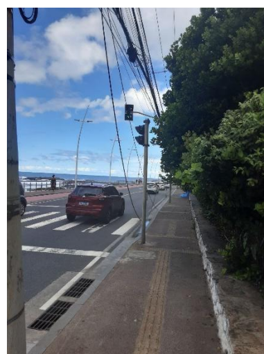
Figura 40 - Fiação solta
