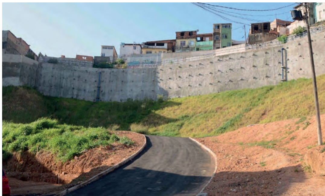
Figura 44. Obras de Contenção de Encosta – Barro Branco (Alto do Peru). Foto: SECOM/PMS
