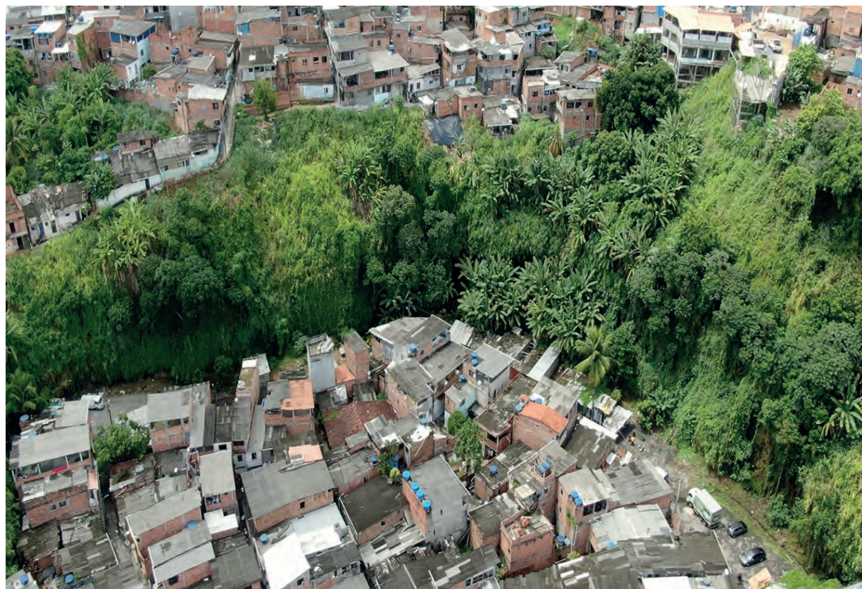
Figura 27. Vista geral da Rua Dom Avelar localizada na poligonal de Calabetão III (Calabetão) obtida a partir de drone. Foto: CODESAL, 2023
