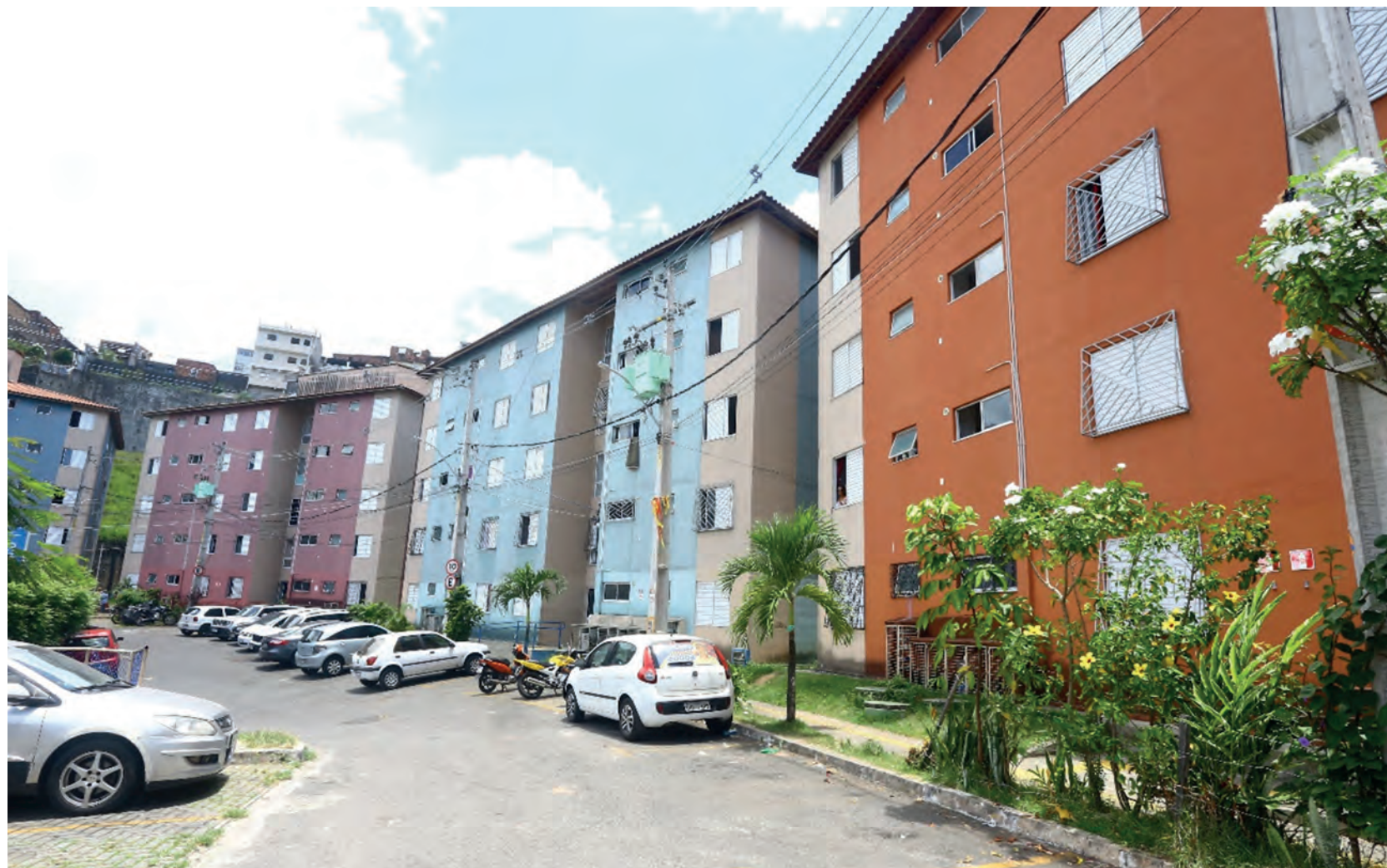
Figura 6. Construção do Conjunto Habitacional Barro Branco (Alto do Peru). Foto: CODESAL
