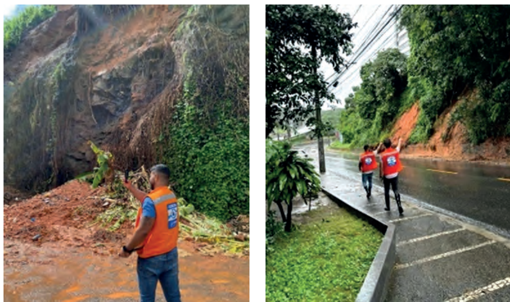
Figura 19. Equipes da CODESAL realizando o trabalho de monitoramento das áreas de risco geológico da cidade. Foto: CODESAL, 2024
