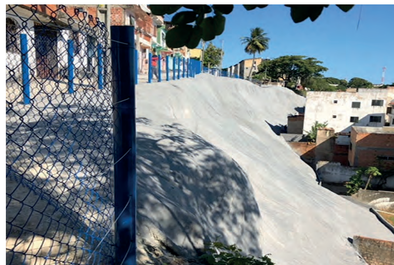
Figura 20. Vista geral da geomanta do Conjunto ACM (Cabula). Foto: CODESAL, 2021
