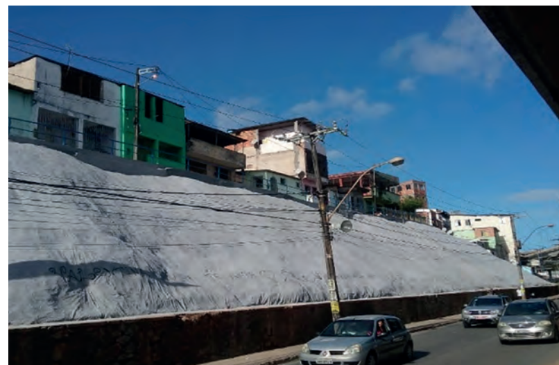
Figura 19. Vista geral da geomanta da Rótula do Abacaxi (Pernambúes). Foto: CODESAL
