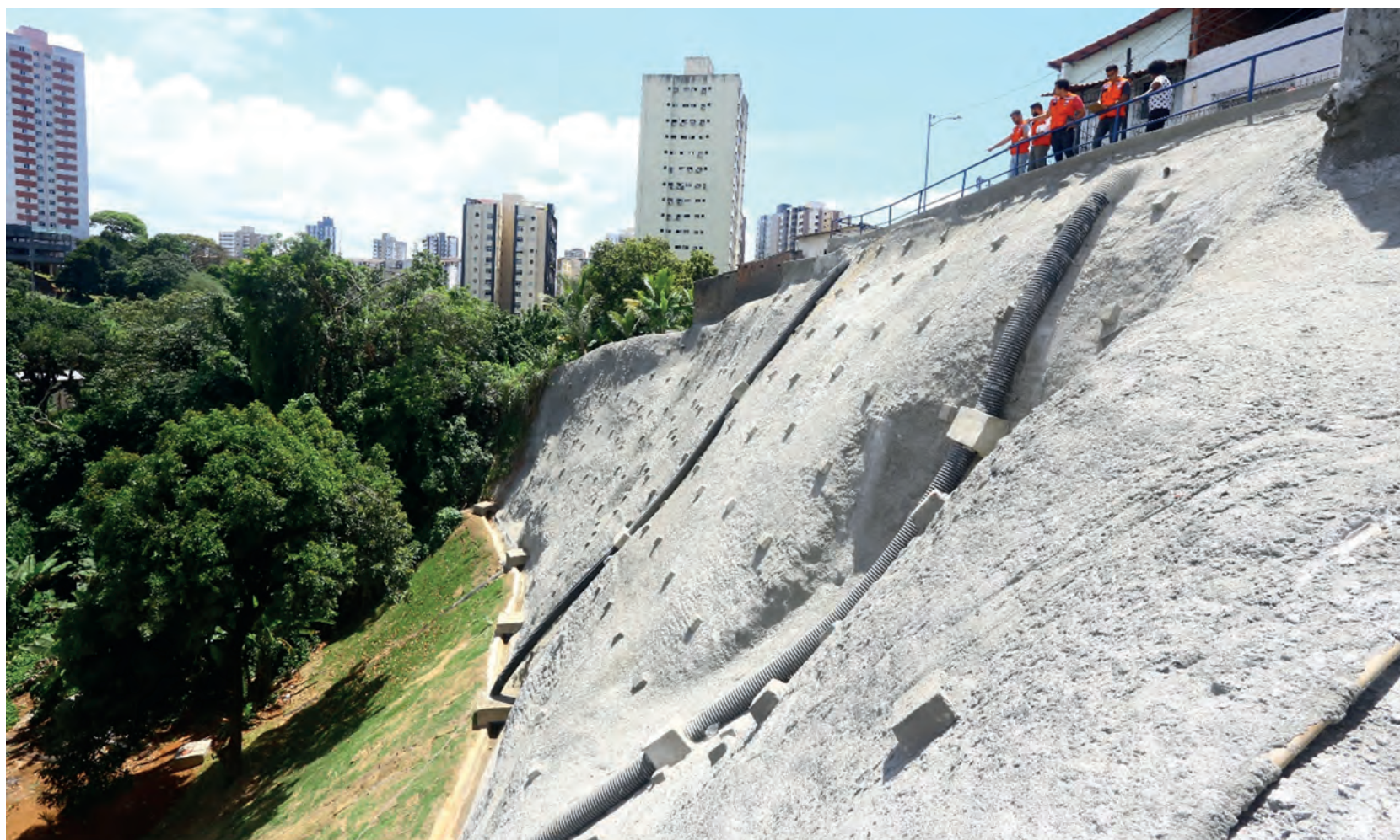
Figura 2. Construção de Contenção – Rua Emília Couto (Brotas). Foto: CODESAL
