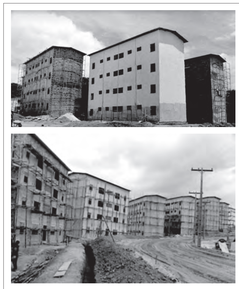
Figura 8. Construção de conjunto habitacional da URBIS – Cabula VI e Saboeiro.
