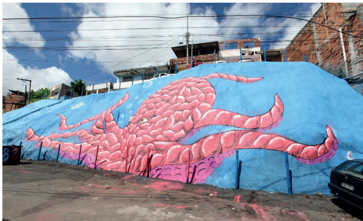
Figura 18. Vista geral da geomanta da Estrada Campinas (Lobato). Foto: CODESAL, 2021
