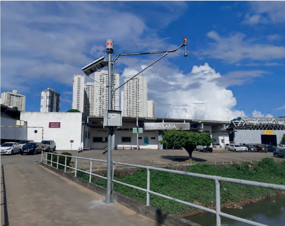
Figura 11. Estação Hidrológica instalada na Av. Barros Reis (Retiro). Foto: CODESAL, 2024
