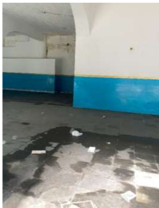
Figura 14: Água acumulada no piso e infiltrações na parede ao fundo.
