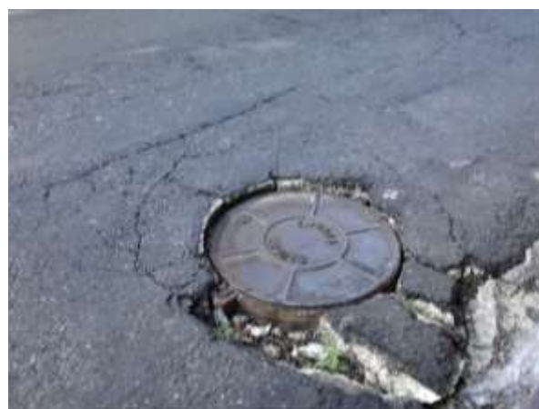
Figura 32: Asfalto danificado.
