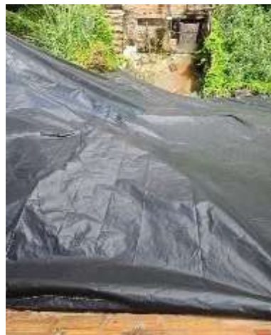
Avenida Elza - Campinas de Pirajá (137253)
