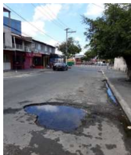
Figura 40: Asfalto danificado.
