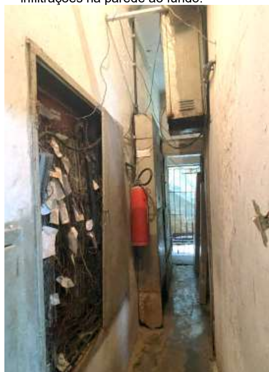
Figura 14: Água acumulada no piso e infiltrações na parede ao fundo.
