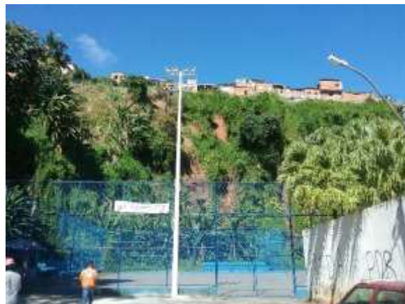
Figura 2: Encosta com presença de vegetação ineficiente, podendo ser observado cicatrizes de deslizamentos na parte do topo – Pedreira São Gonçalo.
