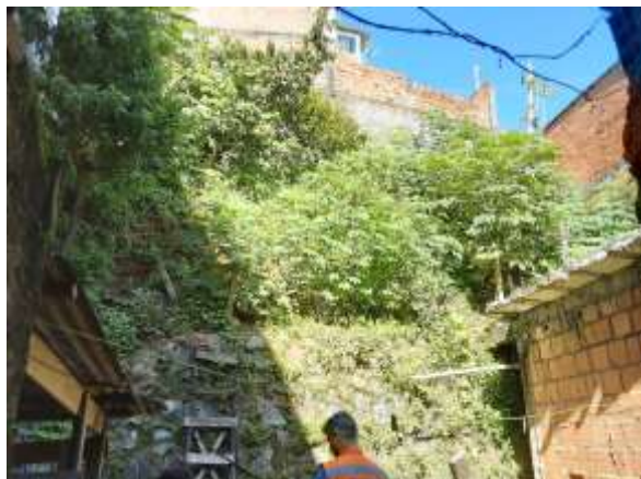
Figura 1: Monitoramento de encosta – poligonal Pedreira São Gonçalo.
