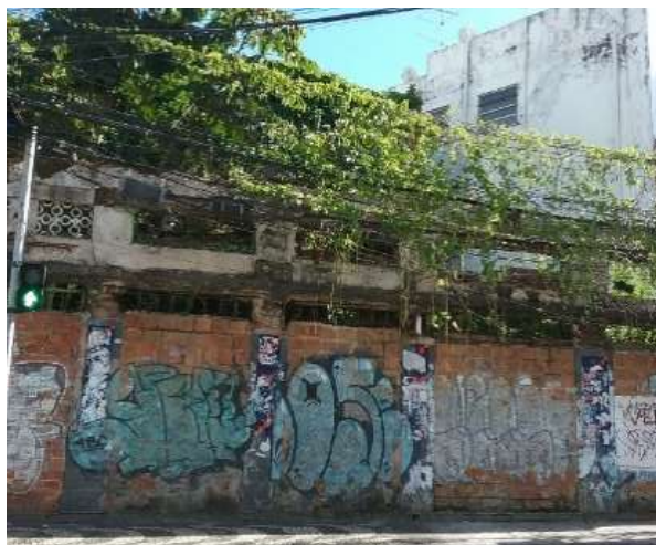
Figura 11: Casarão Rua Leovigildo Filgueiras, vistoriado em junho/2024
