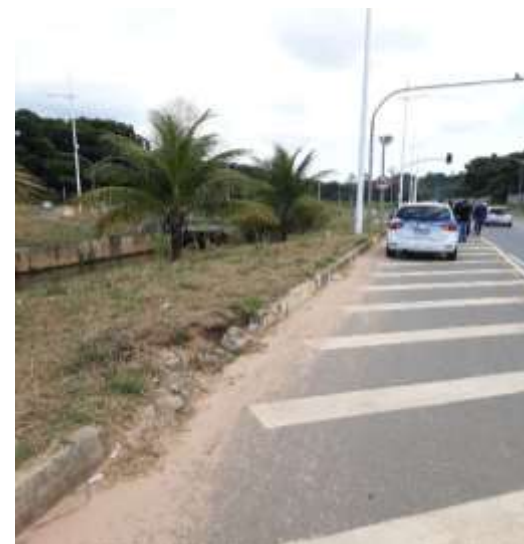
Figura 56: Meio-fio danificado.
