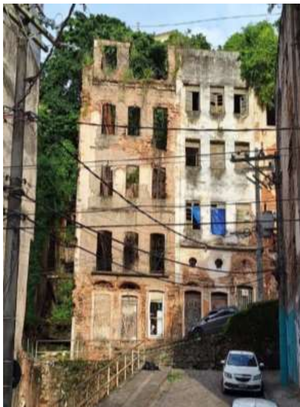
Figura 9: Casarão Caminhão Novo do Tabuão, nº29 – vistoriado em abril/2024.
