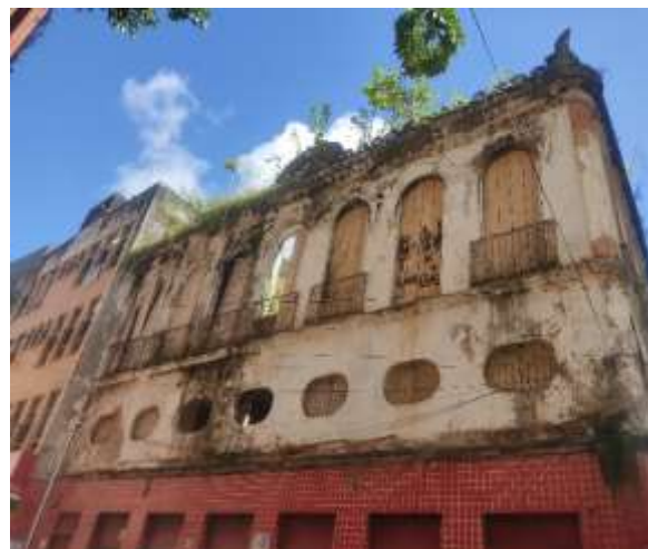
Figura 12: Casarão Rua do Corpo Santo, nº 18 nº 594 – vistoriado em junho/2024.
