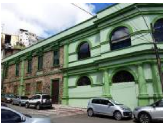
Casarão Trapiche Barnabé vistoriado em maio/2023.
