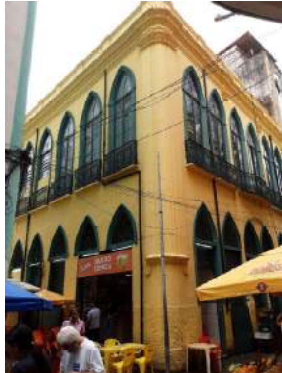
Casarão Rua Álvares Cabral, 69 vistoriado em maio/2023.
