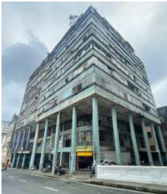
Edifício Excelsior vistoriado em Junho/2023.
