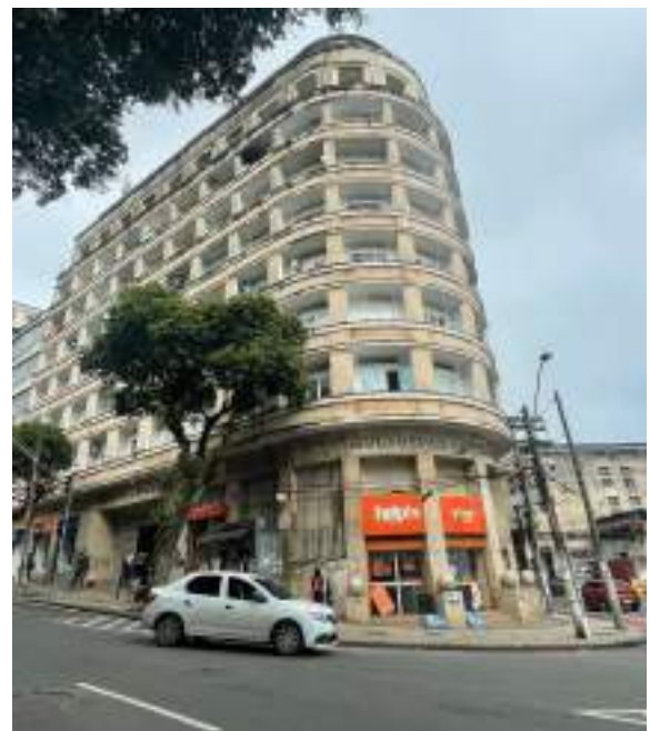
Edifício Sulacap vistoriado em Junho/2023.
