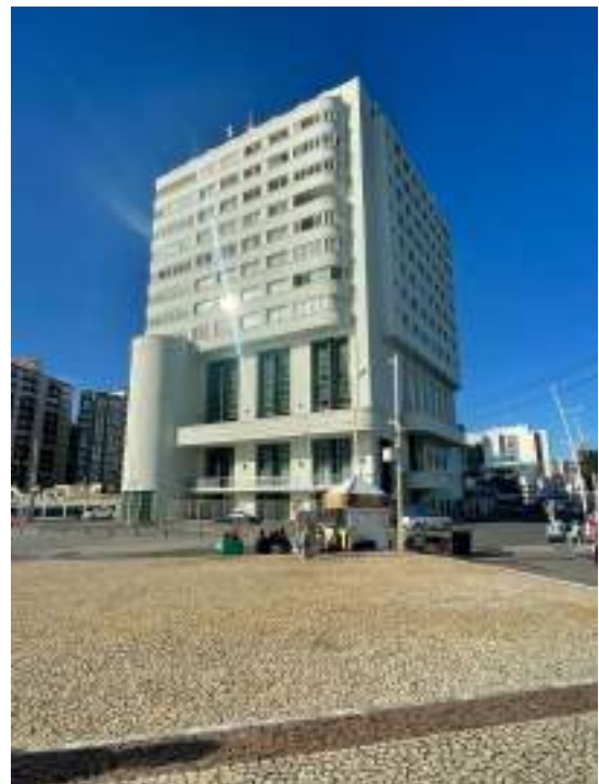
Edifício Oceania vistoriado em Junho/2023
