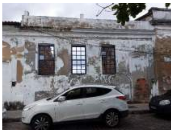
Casarão Rua Monte Serrat vistoriado em abril/2023.
