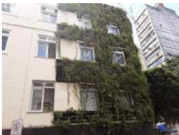
Edifício da SECIS vistoriado em abril/2023.
