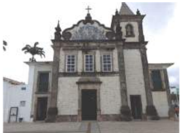
Igreja da Boa Viagem vistoriada em maio/2023..
