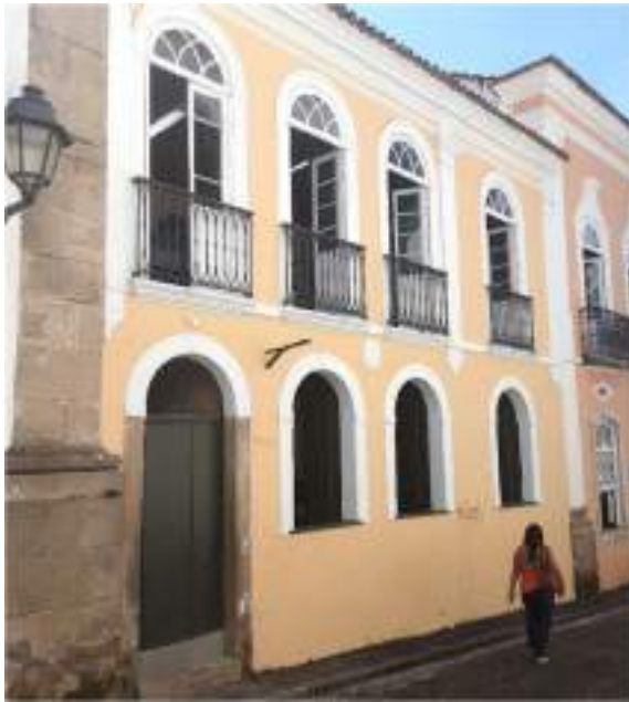
Casarão Rua das Laranjeiras, nº 658 – vistoria realizada em abril/2023.
