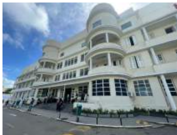
Hospital Aristides Maltez vistoriado em junho/2023.
