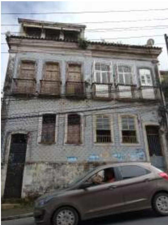
Casarão Lar São José vistoriado em Junho/2023.
