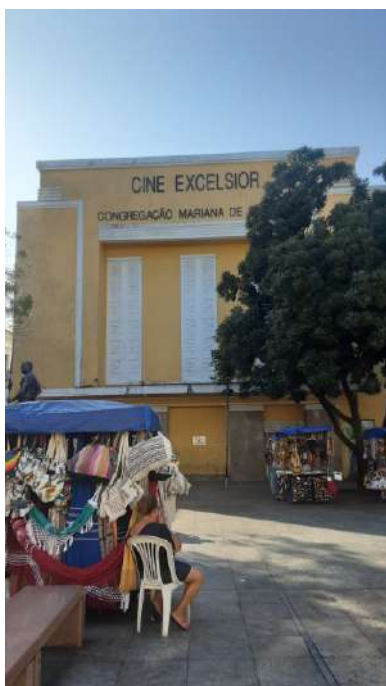
Cine Excelsior - vistoriado em Setembro/2023
