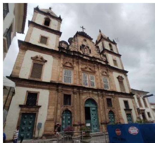
Igreja e Convento de São Francisco vistoriada em Junho/2023
