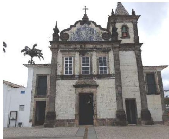
Igreja da Boa Viagem vistoriada em maio/2023.
