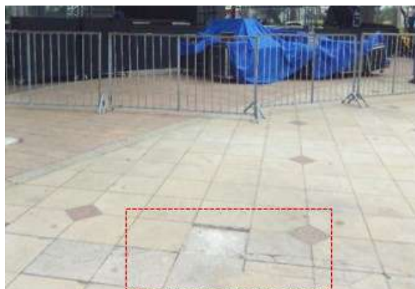
Piso em granito danificado
