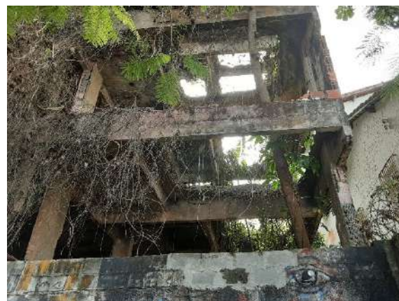
Vista das estruturas.
