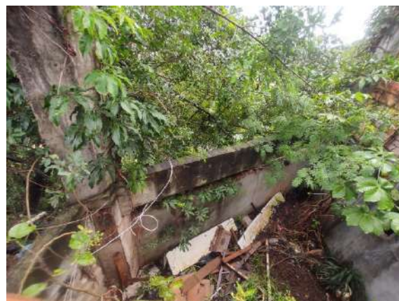
Vista de talude existente.
