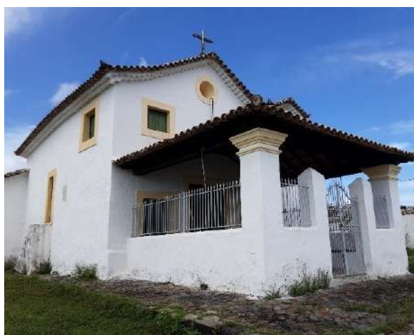
Igreja Nossa Senhora de Escada vistoriada em Junho/2023.
