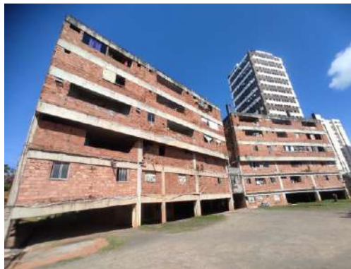
Vista da fachada frontal.
