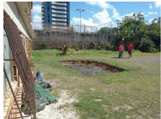
Vista da fossa existente na frente do edifício.
