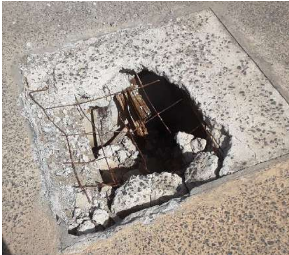
Tampa de concreto danificada.
