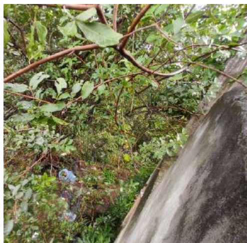
Vista de talude existente no fundo da construção.
