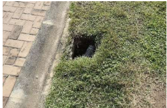
Caixa de drenagem com tampa danificada
