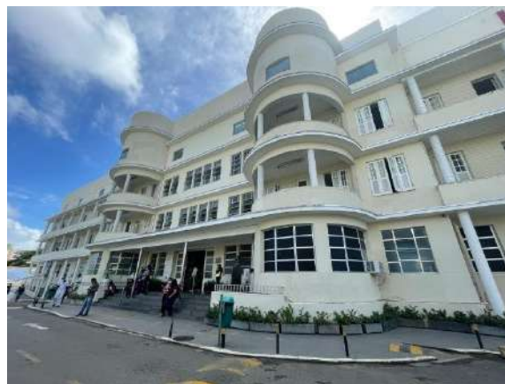
Hospital Aristides Maltez vistoriado em junho/2023.
