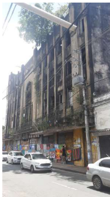
Cine Jandaia - vistoriado em Outubro/20
