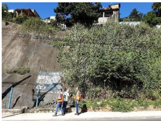
Encosta protegida com Geomanta.
