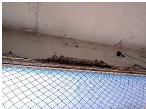
Corrosão de armaduras em viga.
