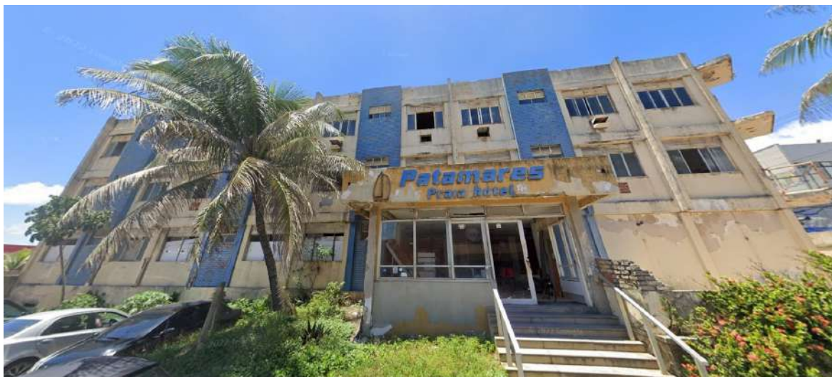
Vista da fachada.
