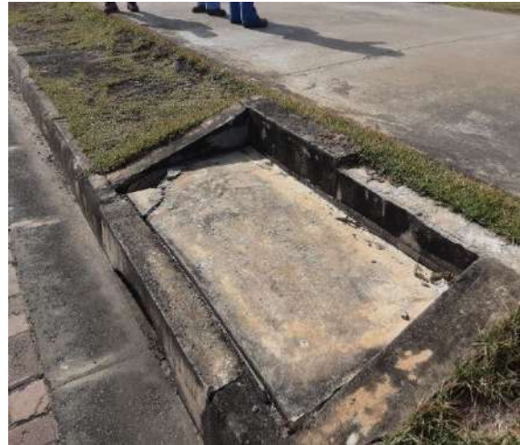
Caixa de drenagem com tampa danificada
