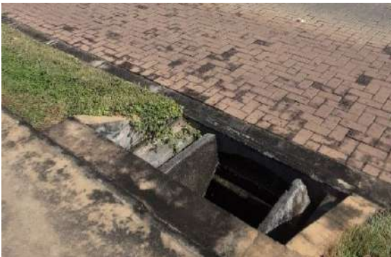
Tampa de concreto danificada.
