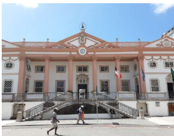
Associação Comercial da Bahia vistoriada em Março/2023.
