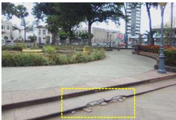
Piso em granito danificado
