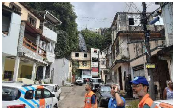
Monitoramento de escostas em áreas de pedreira.
