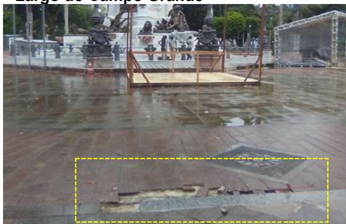
Piso em granito danificado
