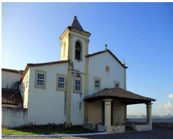
Igreja e Mosteiro de Nossa Senhora de Monte Serrat – vistoriado em Julho/2023.
