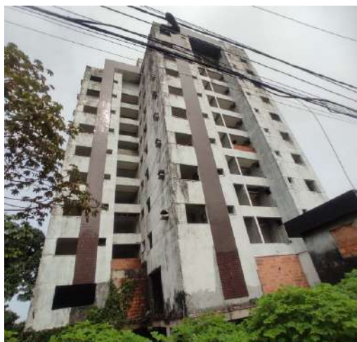
Vista da fachada.
