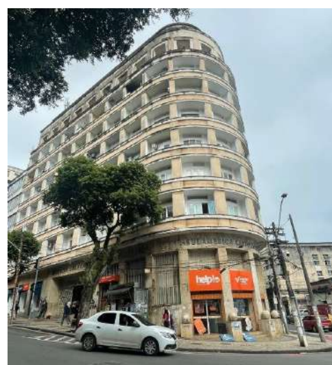
Edifício Sulacap vistoriado em Junho/2023.
