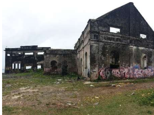
Antiga Fábrica de Tecidos São Brás vistoriada em junho/2023
