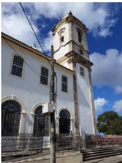
Igreja do Bonfim vistoria realizada em junho/2023.
