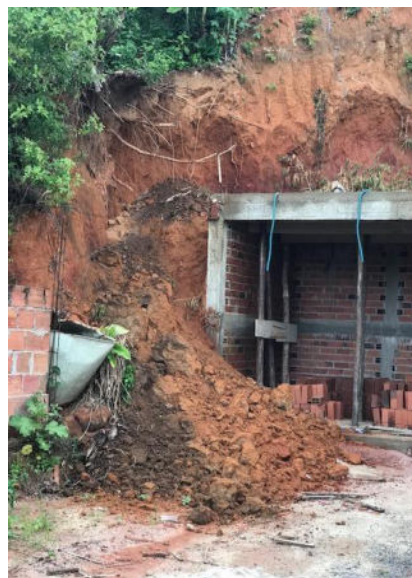
Valéria (Rua Joaquim Macambira) – deslizamento de terra
