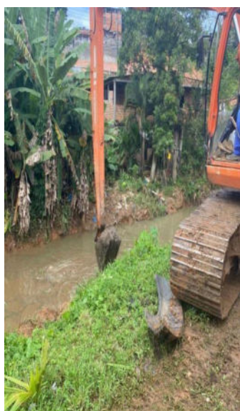
Cajazeiras (Rua Parque Silva Leal – Cajazeiras VI) – Limpeza de canal
