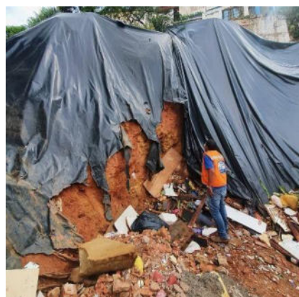
Baixa do Tubo – encosta (recomposição de lona)
