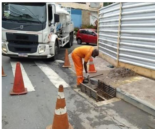
Barra (Rua Recife) – desobstrução da rede de drenagem
