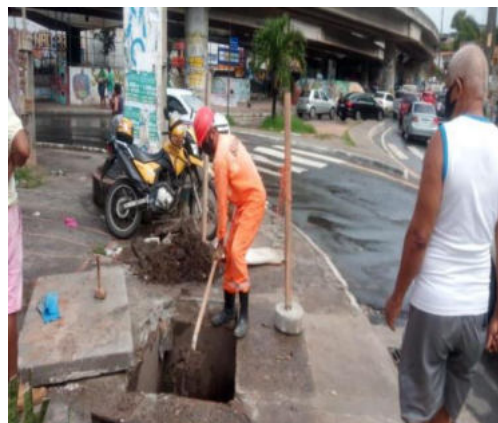
Fazenda Grande do Retiro (Largo do Retiro) – desobstrução de galerias
