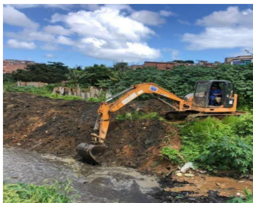
Campinas de Pirajá (Rua Monte Sinai) – limpeza de canal
