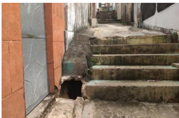
Cabula/Tancredo Neves (Jardim Santo Inácio/ Alameda 45) – reforma da rede pluvial e escadaria.
