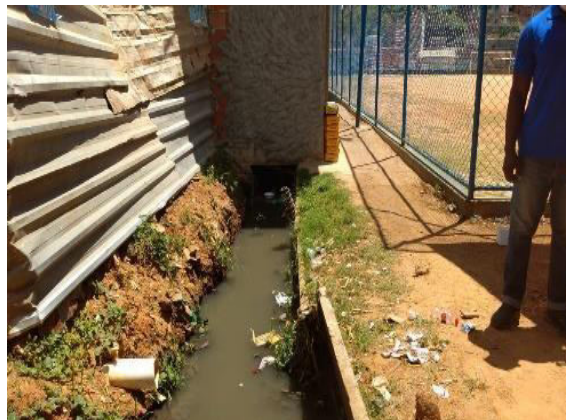
Cabula/Tancredo Neves (Rua Boa Vista – Saramandaia) – drenagem, implantação de rede pluvial e de esgoto.
