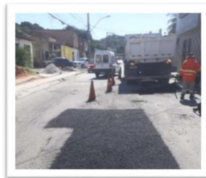
Operação Tapa-Buraco na regional do Subúrbio.
