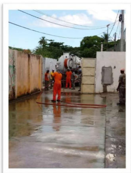
Desobstrução de rede de drenagem
