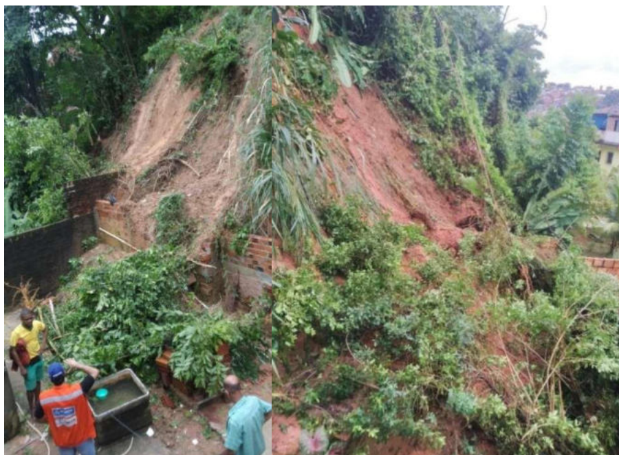
A figura mostra um deslizamento ocorrido na comunidade de Moscou, em Castelo Branco, no dia 23/04/2020, dia anterior ao acionamento de evacuação preventiva na comunidade.
