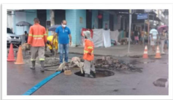
Execução de correção de fuga de material
