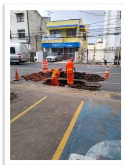
Correção de fuga dematerial na via
