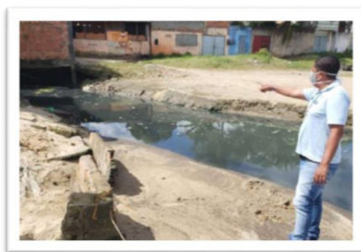
Subprefeito Alan Muniz vistoriando canal na regional.
