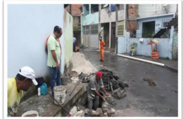
Subprefeito Cláudio vistorian limpeza de sarjeta
