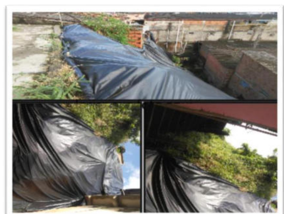
Vistoriando área com risco de deslizamento
