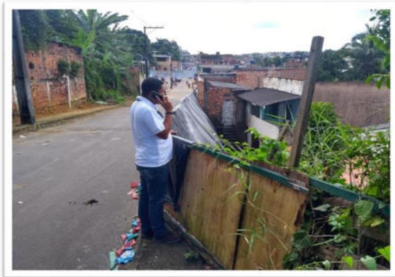
Subprefeito Alan vistoriando área de risco de deslizamento
