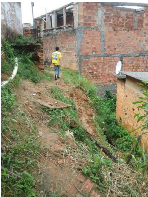
Imóveis em risco de alagamento e acessos precários. Localidade: Moscou I.
