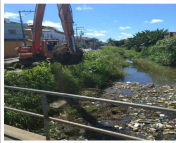
Vistoriando a desobstrução de canal
