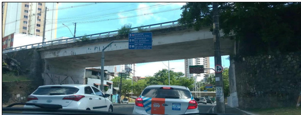
Viaduto do Campo Santo. : Avenida Cardeal da Silva, s/n – Federação.
