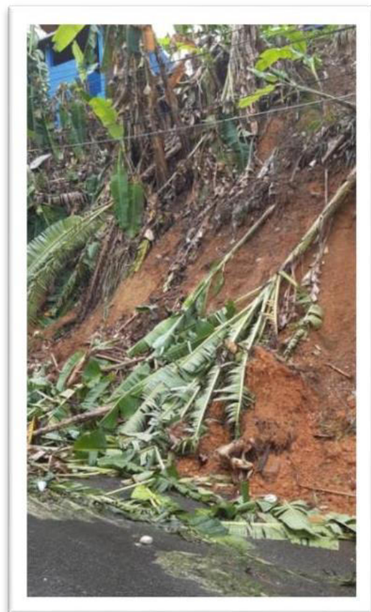
Situação de risco, deslizamento. Encaminhamento para Codesal e Limpurb
