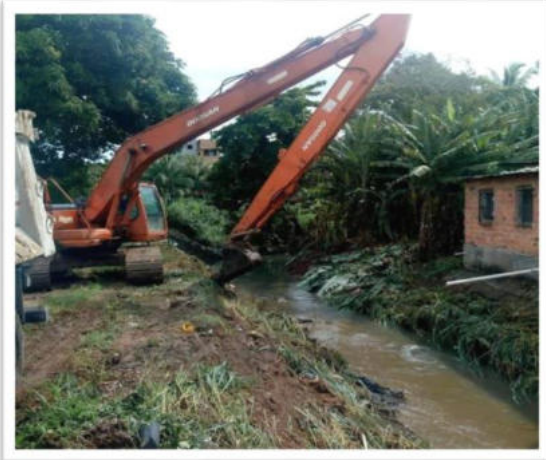
Vistoriando a limpeza do canal, para drenagem de água pluvial
