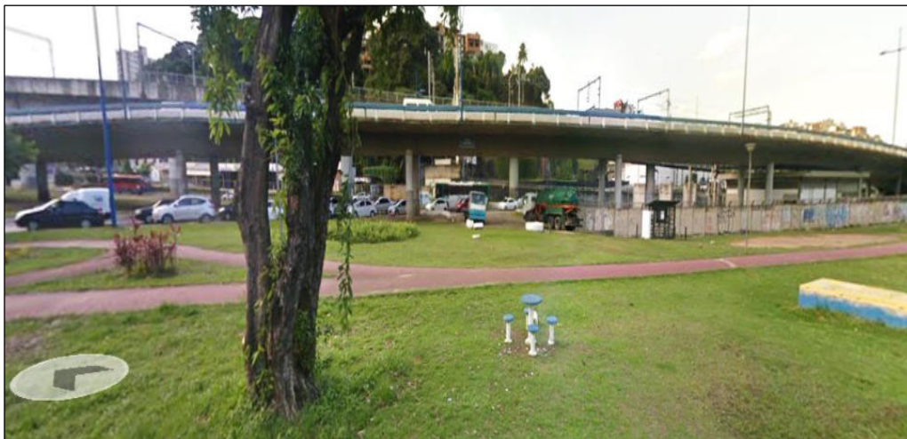
Viaduto Chico Mendes.-: Avenida Mário Leal Ferreira, s/n – Bonocô.
