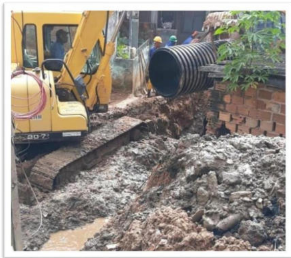
Vistoriando cobertura de canal
