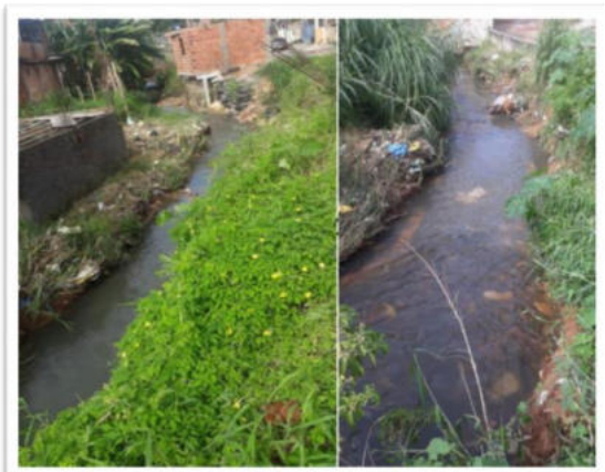
Vistoriando canal e solicitando limpeza
