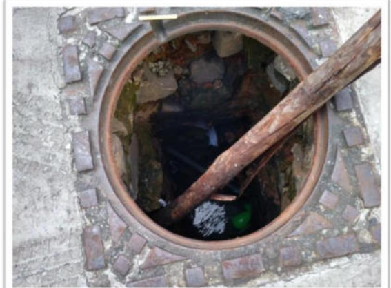
Desobstrução de poço de visita
