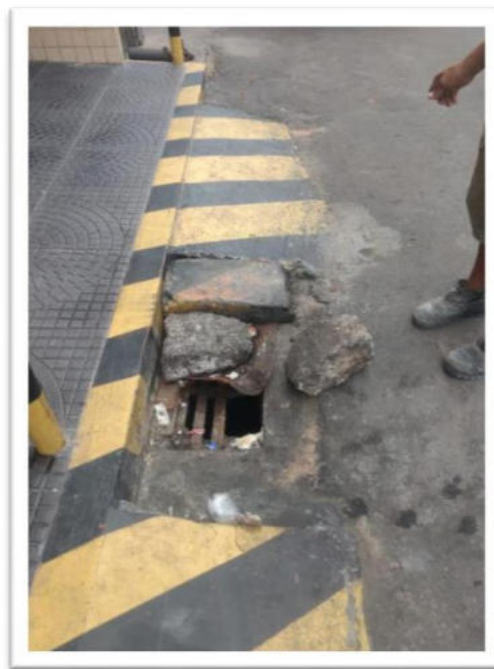
Desobstrução de sarjeta
