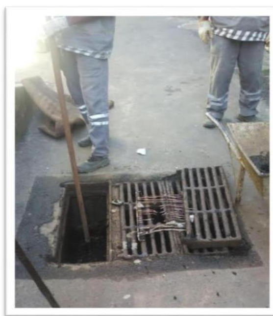
Limpeza na rede de drenagem
