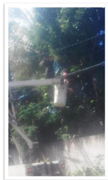
Acompanhamento em podas de árvores
