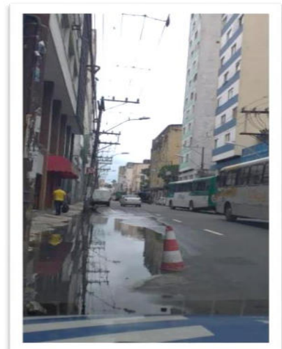
Ponto de alagamento, desobstrução de drenagem
