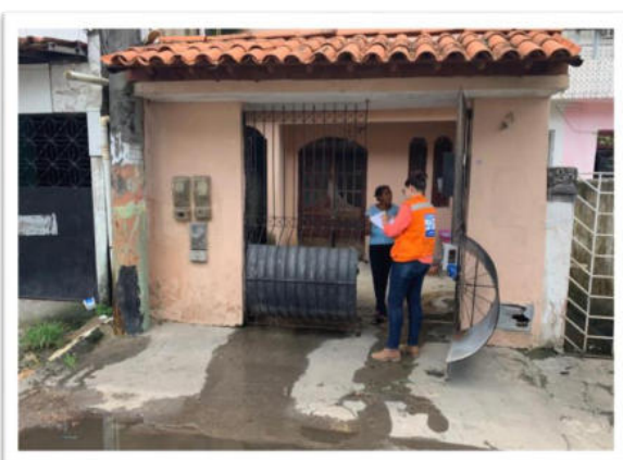
Engenheira Camila Mattos verificando risco de alagamento
