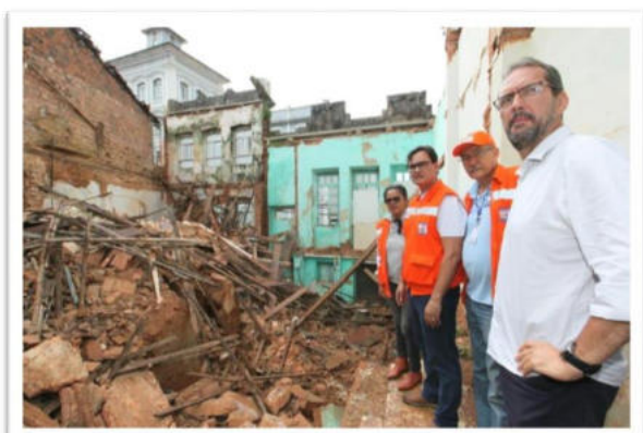
Subprefeito João e o Diretor Geral da CODESAL Sosthenes em vistoria
