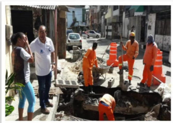
Fuga de material
