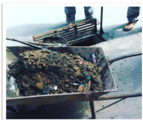
Limpeza em rede de drenagem
