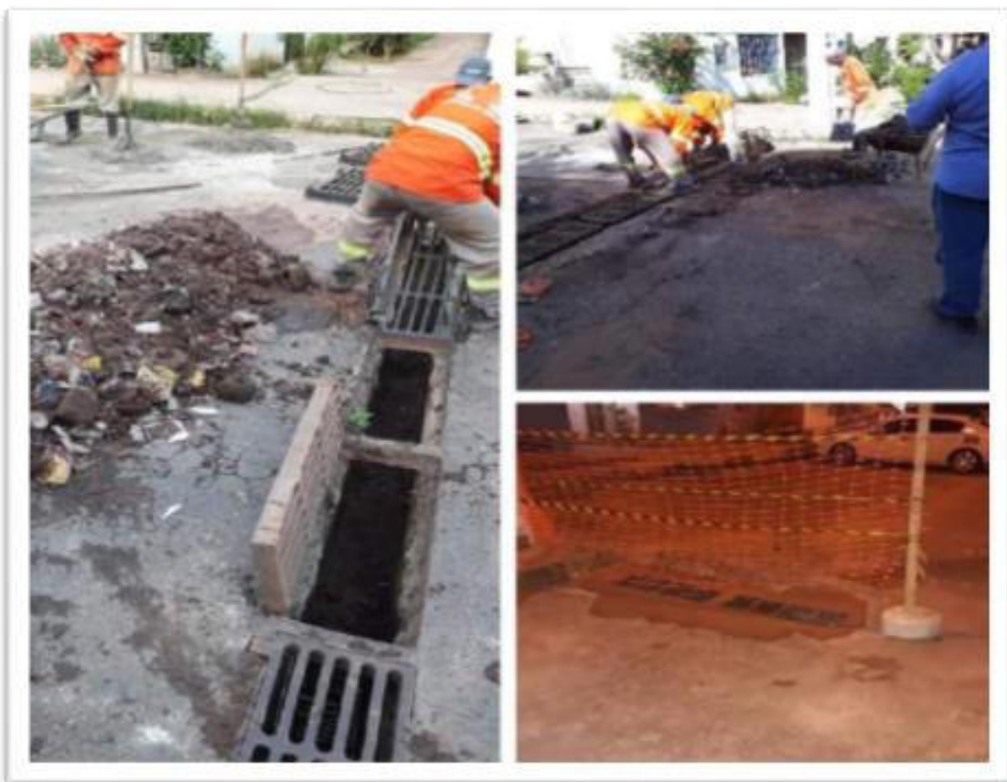
Limpeza em rede de drenagem Imagem
