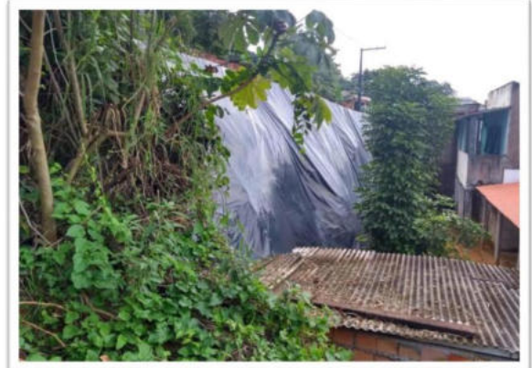
Colocação de lona em área de risco
