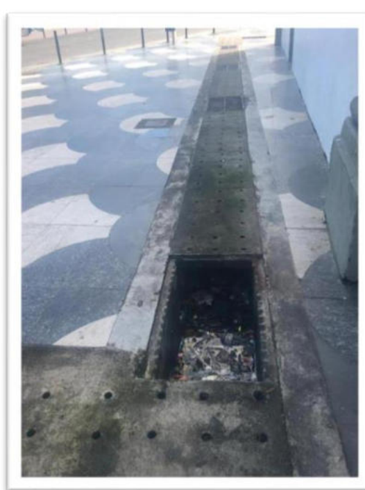
Limpeza na rede de drenagem
