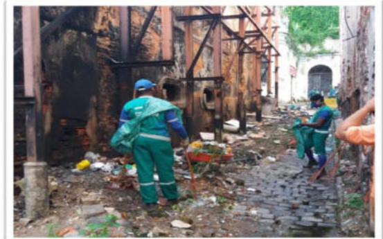
Remoção de resíduos e limpeza da área
