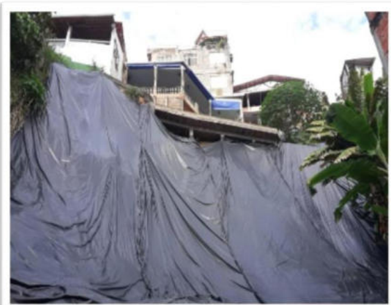
Vistoriando área com risco de deslizamento
