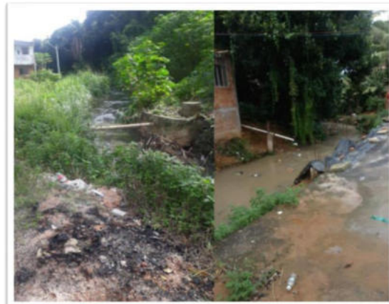
Vistoriando canal e solicitando limpeza
