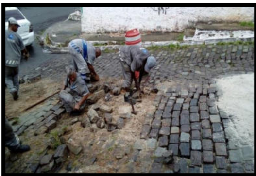
Recuperação de pavimento em paralelo
