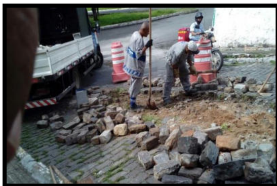
Recuperação de pavimento em paralelo
