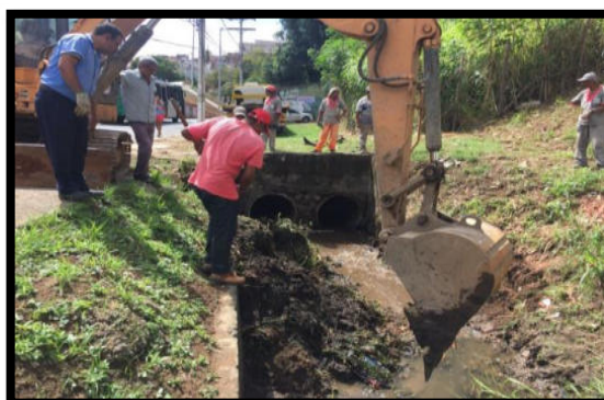
Limpeza mecânica de canal
