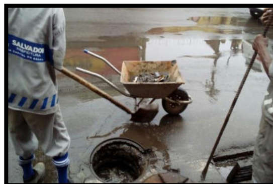
Limpeza de caixa
