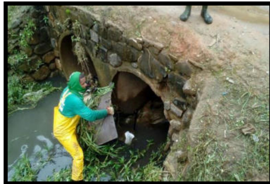
Limpeza manual de canal
