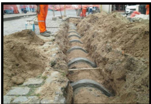
Recuperação de rede de drenagem
