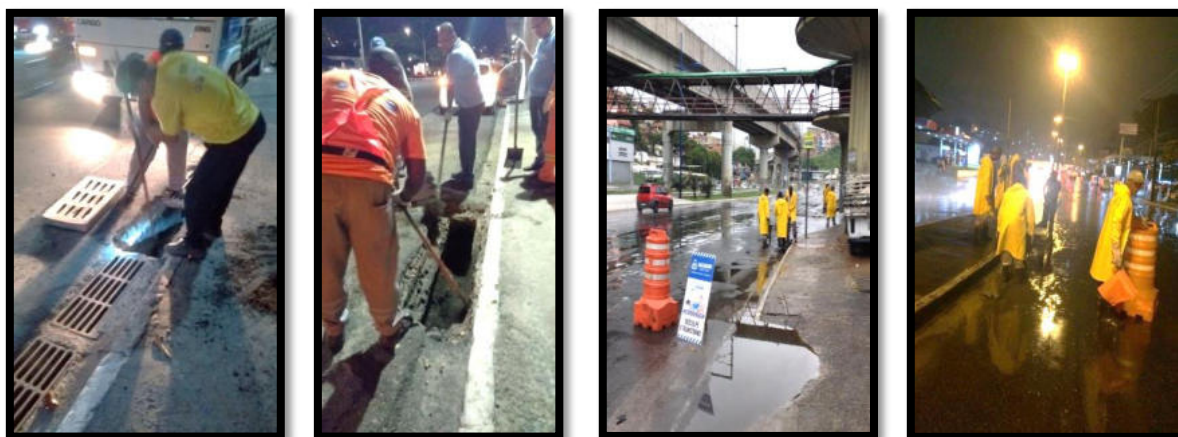
Microdrenagem na Avenida Vasco da Gama – Limpeza de caixas de Sarjetas, de caixas de passagem e da calha lateral da via.
