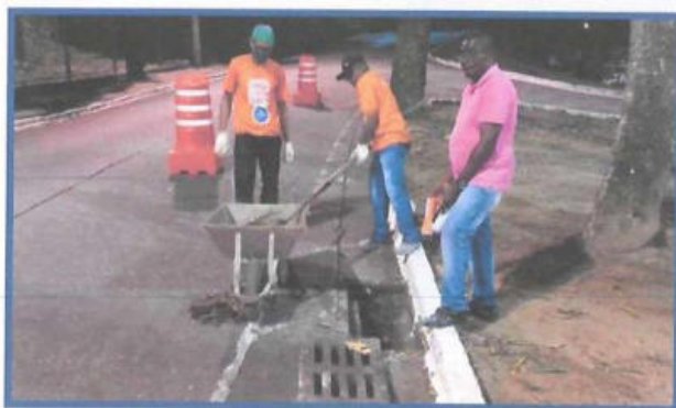
Viaduto Vale Canela - Graça
