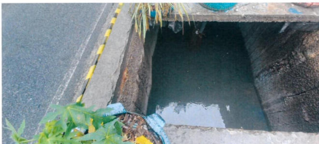
Caminho de Areia (Rua Jardim Castro Alves) – bate-estaca, manutenção corretiva das tampas de concreto que fecham o canal
