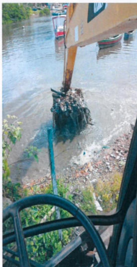
Massaranduba (Rua do Leblon) – limpeza da rede de drenagem com retroescavadeira
