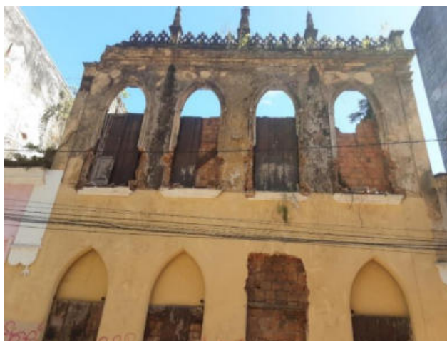
Maio 2022 – Intervenção na fachada para isolamento dos vãos abertos e retirada dos pináculos
