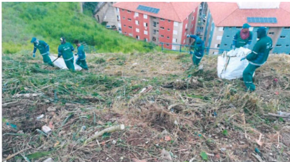
Fazenda Grande do Retiro (Vila do Barro Branco) – limpeza de vala e capinação
