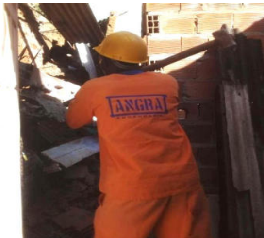
Demolição de imóvel – Cajazeiras VIII
