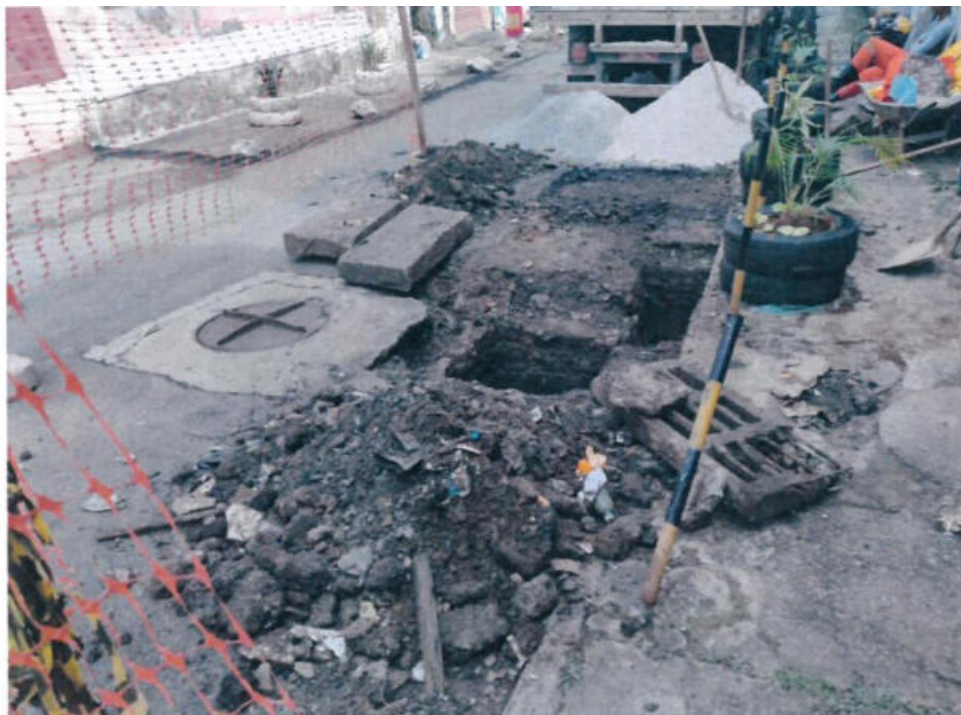
Cidade Nova (Rua Av. Passos) – desobstrução de caixa de água fluvial
