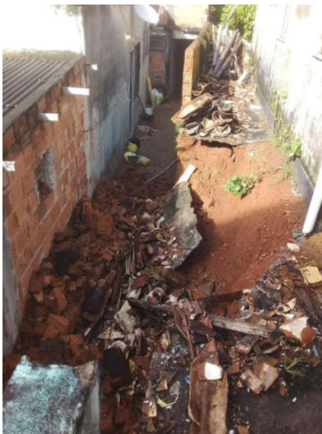
Remoção de escombros – São Caetano
