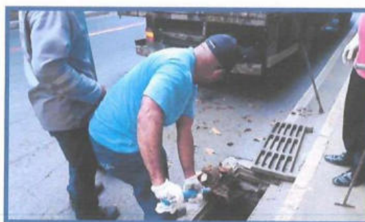
Avenida Centenário - Barra
