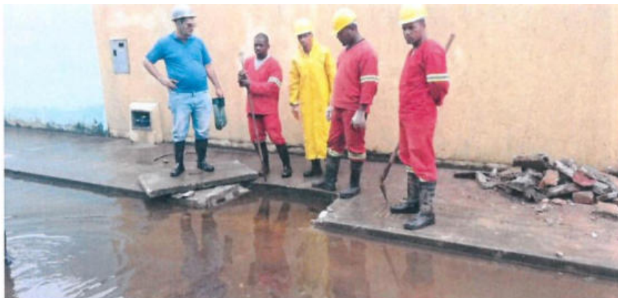
Praia do Flamengo (Rua Ipecaetá, Marisol) – alagamento/ retirada de bloqueio do Rio
