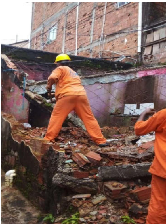
Demolição de imóvel – Tancredo Neves
