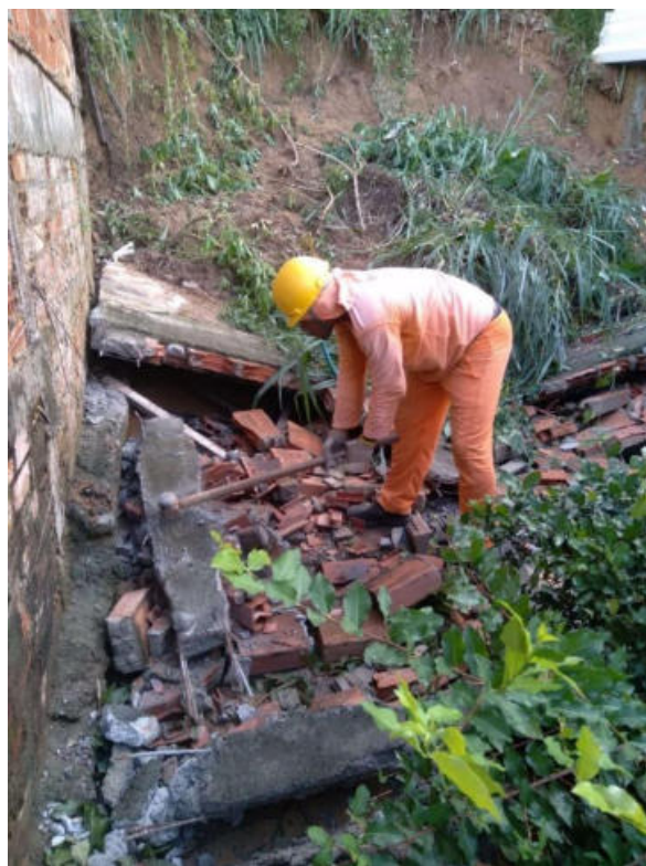
Demolição de muro – Alto de Coutos
