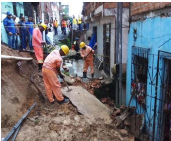
Demolição de remanescente – Uruguai
