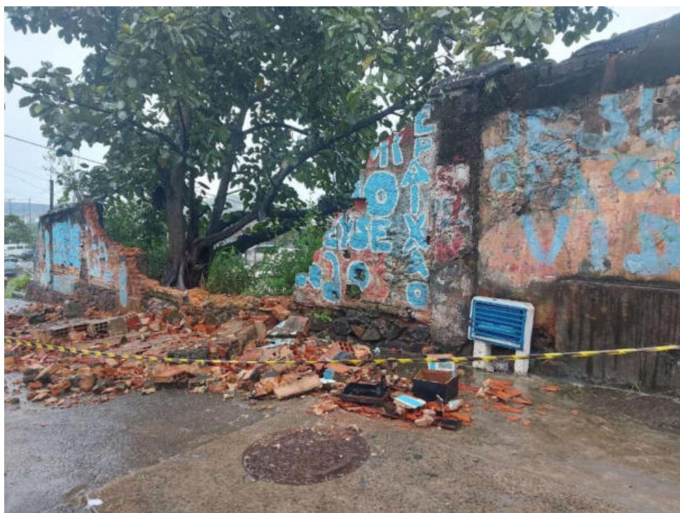
Demolição de remanescente – Uruguai
