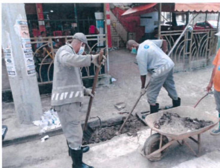
Pituba – limpeza e desobstrução dos sistemas de drenagem
