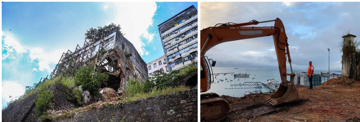
Demolição do casarão da Rua do Pau da Bandeira, s/n – Centro Histórico.
