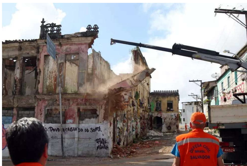
Demolição do casarão da Ladeira da Soledade, nº 95/97 – Barbalho.
